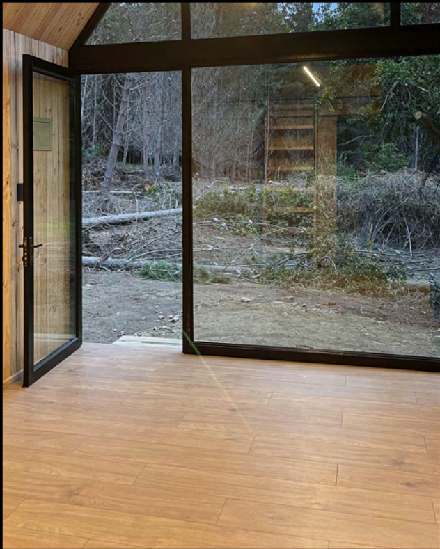
Piso orgánico de origen Alemán, hidrófugo y anti rallas, instalado con Manta Aquastop 10 mm.
